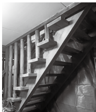
宿の壁はなくブルーシートがかけられていた
